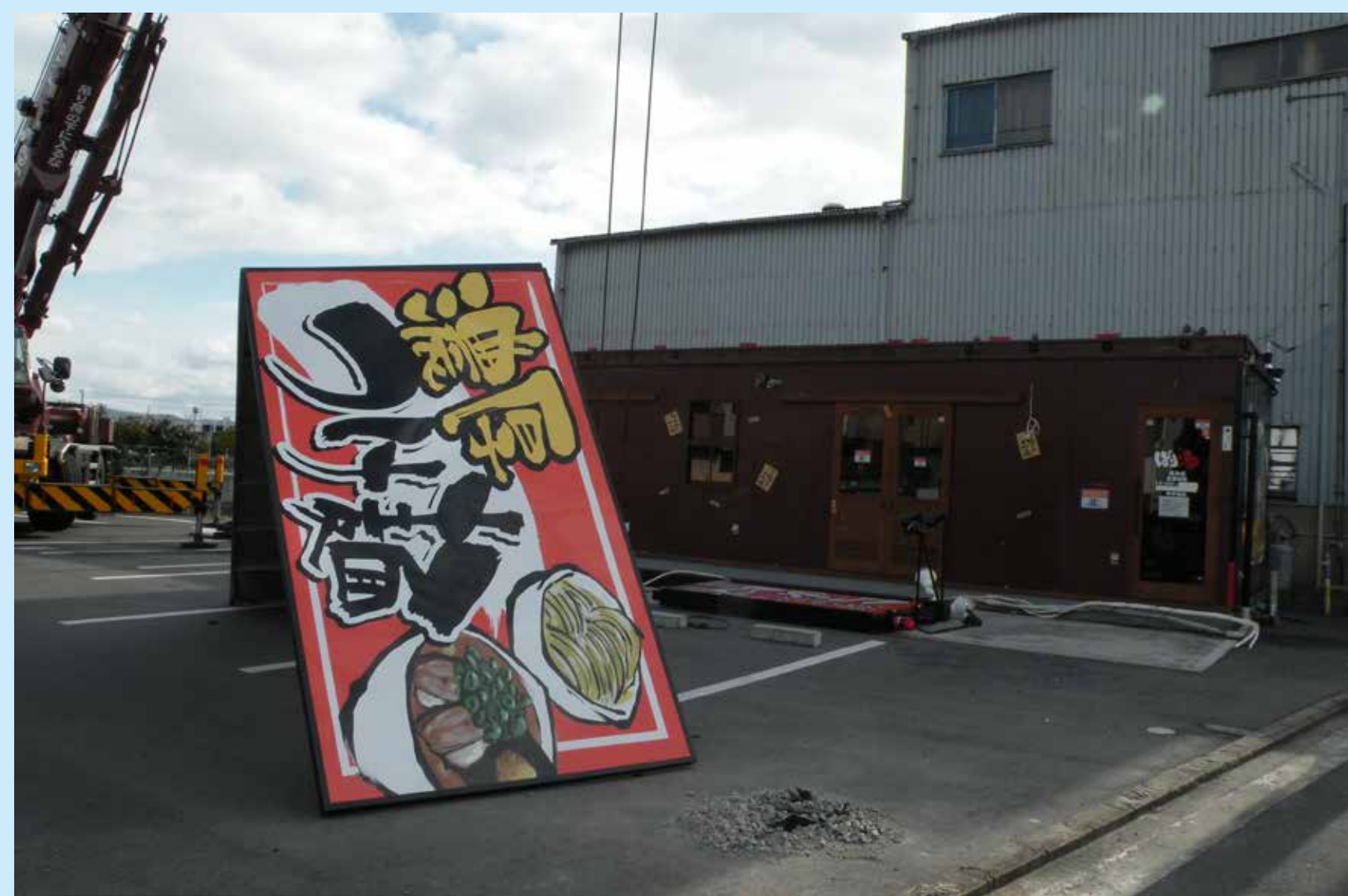
移設工事（分解 2日～3日）
