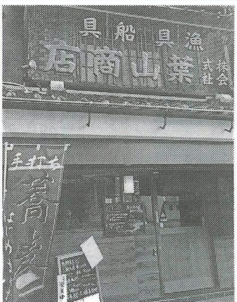
▲船具を扱っていた空き店舗を、昔の看板を残したまま、地元の軟水を使ったそば屋に改修した。昼時には席がいっぱいになることも
